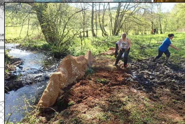
Fascine vive Branches de saules capable de rejeter Diam. 3 à 5cm, longueur >2m Lit de branches anti-affoulement Ramilles de saule ou autre, Inclinaison de 10° Diam. 1 à 3cm, longueur >70cm
